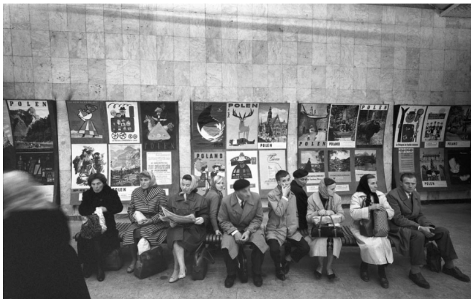
Il. 1. Zbyszko Siemaszko: Warszawa Śródmieście railway station , 1963
